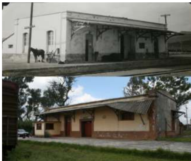
12. Estación Somorriél en 1928 y en la actualidad.
