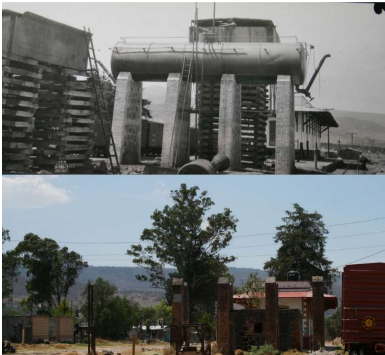
13. Patios de la estación Ventoquipa.
